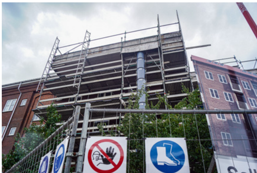
Tømrersjakket nedlagde arbejdet efter flere arbejdsulykker på stilladset.
